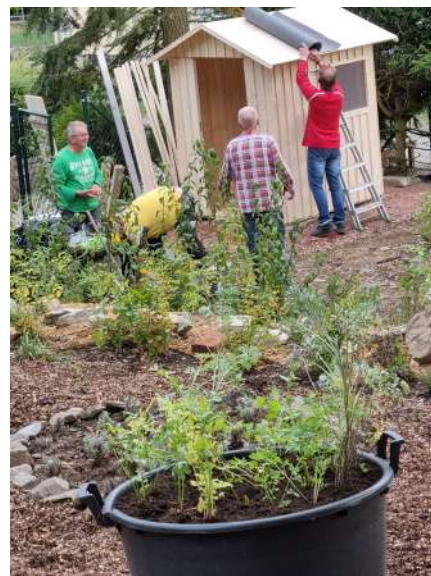
... wie der gemeinsame Bau des Geräteschuppens ...
